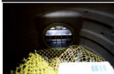
1 - Dévisser le tampon Ø 400 mm côté Sortie
