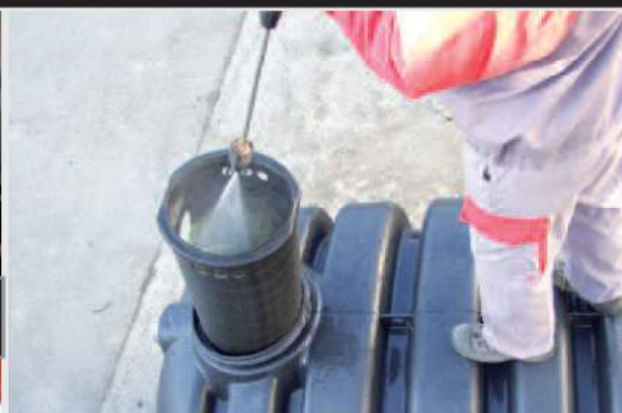
5 - Bloquer le préfiltre en calant le fond en biais sur le manchon de sortie. - Laver au jet haute pression le filet. - Préfiltre permettant l'écoulement des eaux de lavage dans l'appareil.
