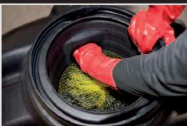
2 - Introduire la main dans le manchon amovible pour agripper la poignée
